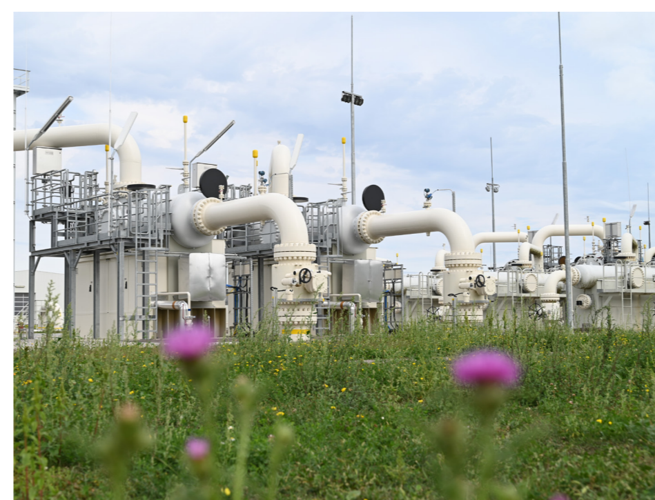
Filteranlage
